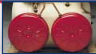
Vaso di espansione per circuito di riscaldamento.
